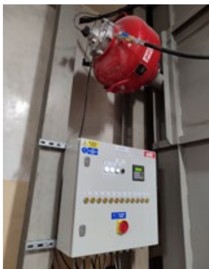
FOT. 1. Układ iUS do sterowania systemem pulsatorów i odbijaków na zbiorniku z otrębami [ZŹRÓDŁO: INWET SA]
