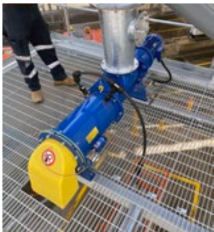
FOT. 3 Mieszalnik flotacyjny marki WAMGROUP [ZŹRÓDŁO: WAMGROUP]
