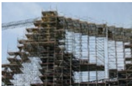
FOT. 1.7 Rusztowanie modułowe (klatkowe)
