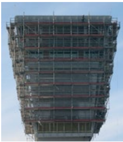
FOT. 1.1 Rusztowanie robocze
