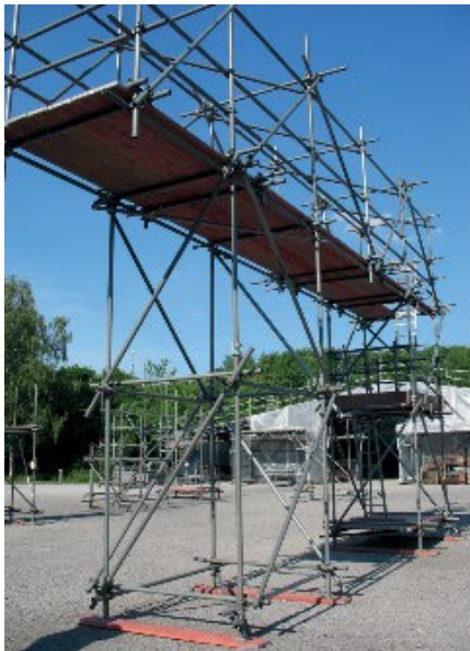
FOT. 1.6 Rusztowanie stojakowe rurowo-złączkowe
