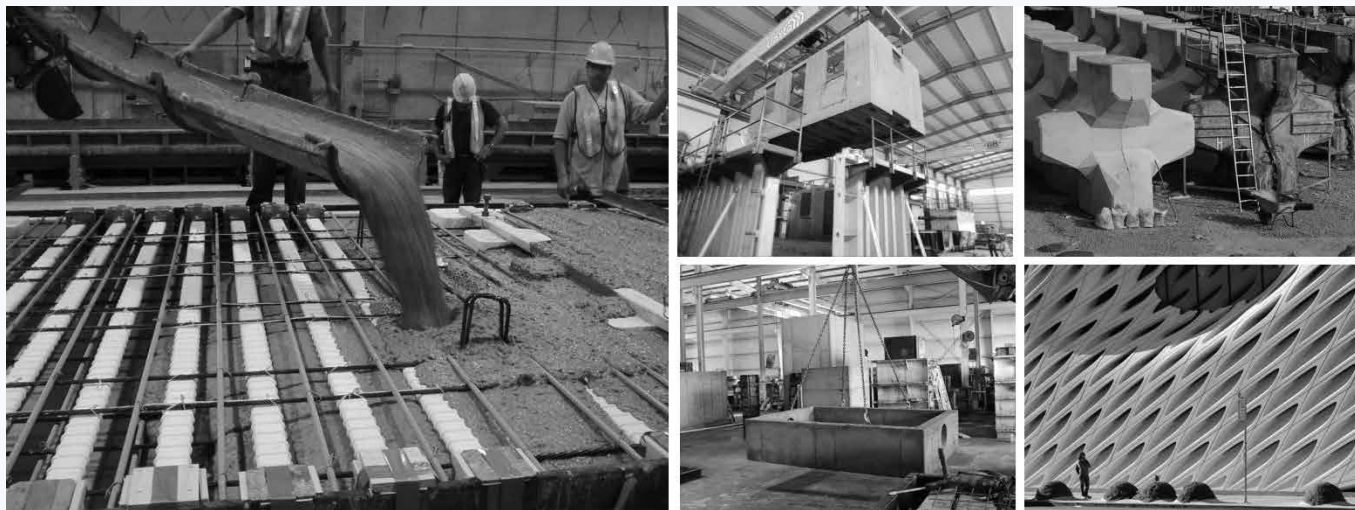
FOT. 2 Beton BSZ w prefabrykacji
