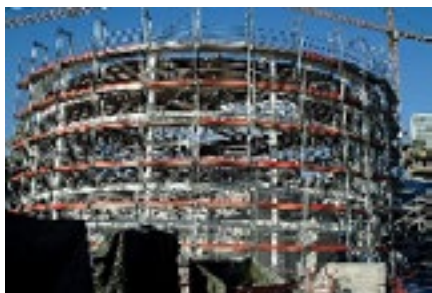
FOT. 1.5 Rusztowanie ramowe: – zabudowa cylindryczna
