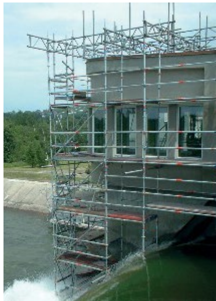
FOT. 1.9 Rusztowania wspornikowe – wiszące
