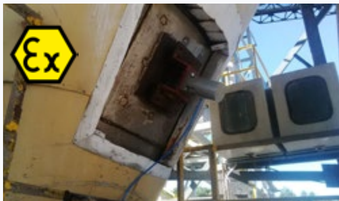
NA ZDJĘCIU: Wibroodbijaki FPK-Ex zainstalowane na silosach z domieszkami
