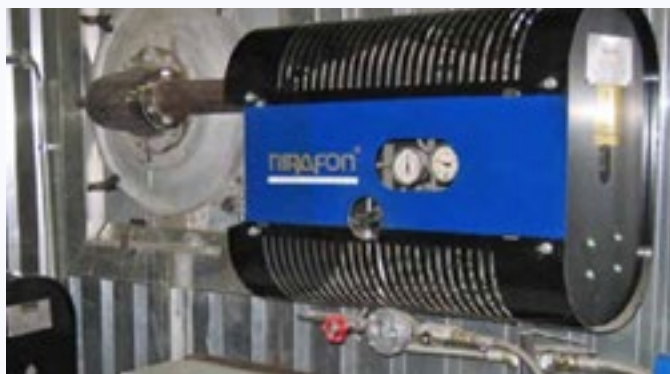
FOT. 2, 3 Zdmuchiwacz akustyczny Nirafon® NCS zainstalowany na obiekcie
