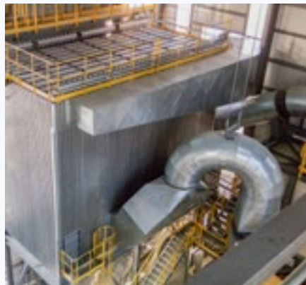
FOT. 3 Wielkogabarytowy filtr odpylający marki WAKRO [źródło: WAKRO]
