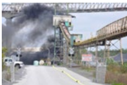
FOT. 2 Pożar taśmociągu [ZŹRÓDŁO Senkox]
