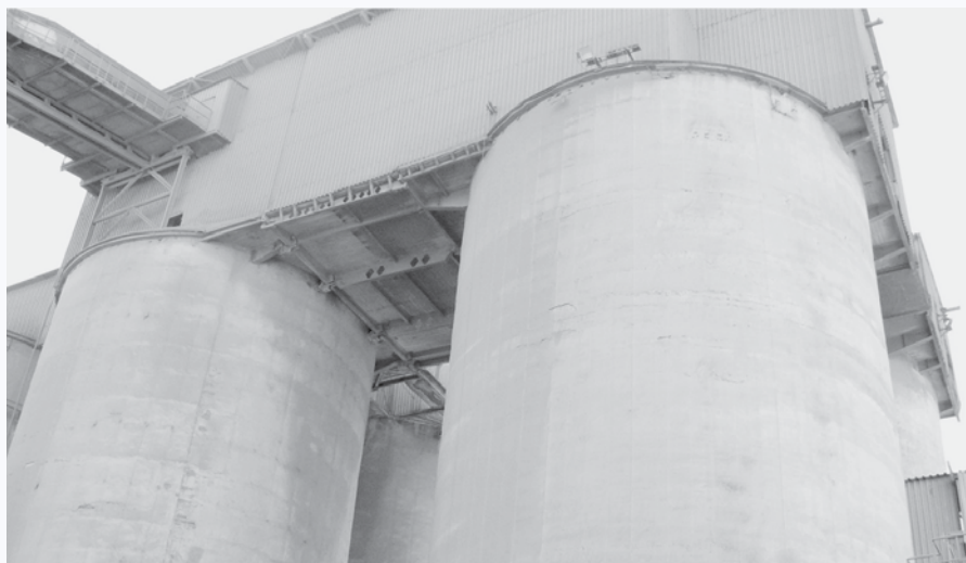
FOT. 5 Stalowa konstrukcja galerii nadsilosowej w baterii wielokomorowej widziana od dołu
