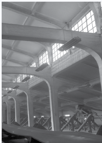
FOT. 4 Żelbetowa konstrukcja ramowa galerii nadsilosowej w elewatorze zbożowym z okresu międzywojennego
