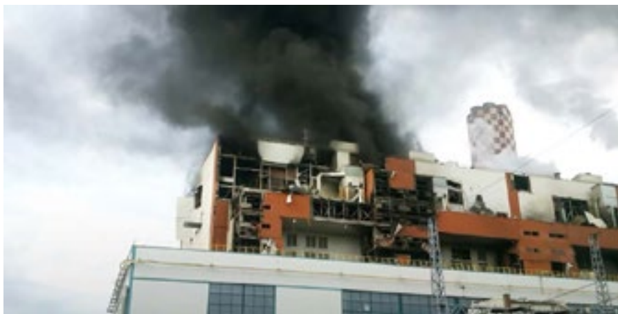
FOT. 1 Wybuch w Elektrowni Turów
