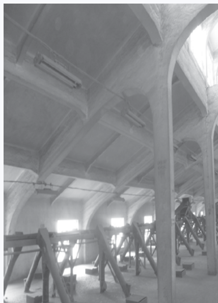
FOT. 4 Żelbetowa konstrukcja ramowa galerii nadsilosowej w elewatorze zbożowym z okresu międzywojennego
