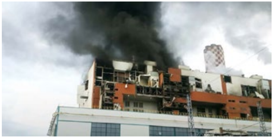
FOT. 1 Wybuch w Elektrowni Turów
