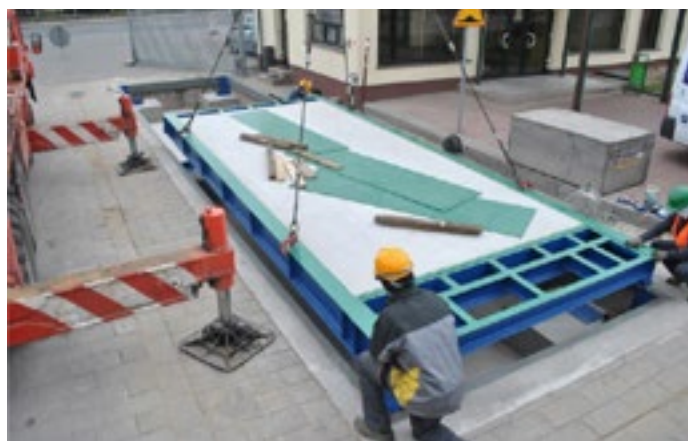
FOT. 7 Montaż ramy wagi samochodowej PCM [ZŹRÓDŁO: PCM]
