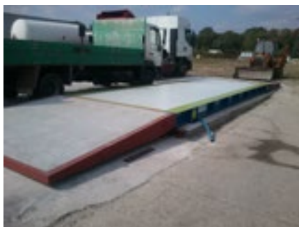
FOT. 10 Waga stalowo-betonowa [ZŹRÓDŁO: P CM]
