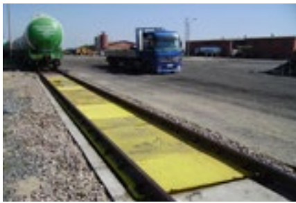
FOT. 9 Waga kolejowa [ZŹRÓDŁO: Automatyka Serwis]
