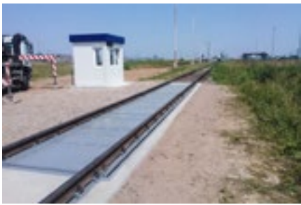
FOT. 8 Waga kolejowa [ZŹRÓDŁO: Automatyka Serwis]
