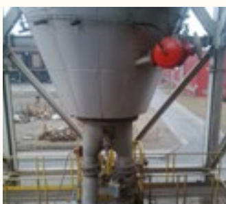
FOT.1 Układ pulsator, odbijaki i wibrator w wersji HT – silos „prażonki”
