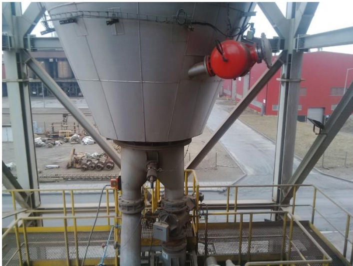
FOT. 1 Układ pulsator, odbijak i wibrator w wersji HT – silos „prażonki”
