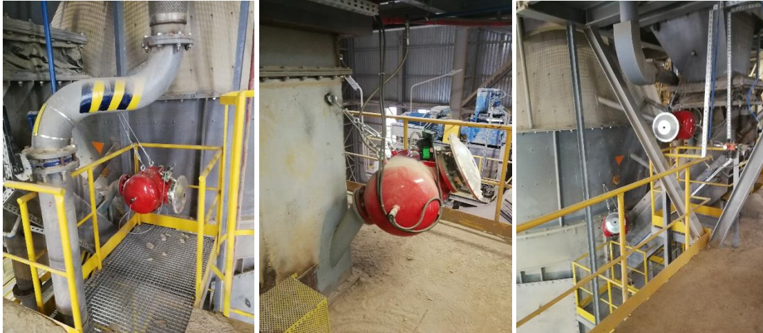
FOT. 3, 4, 5 Pulsatory SYNEX na zsykach do młyna cementu żuźlowego
