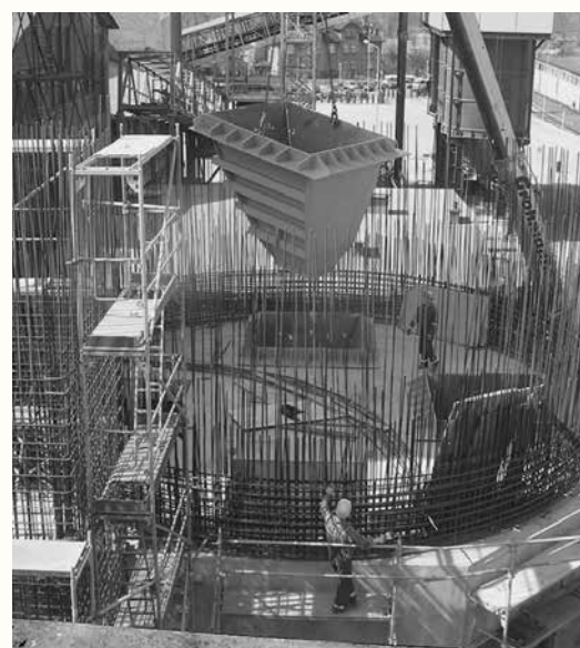
FOT. 9 Lej stalowy w silosie na klinkier w czasie montażu w jednym z czterech otworów wyspowych [Uniserv S.A.]
