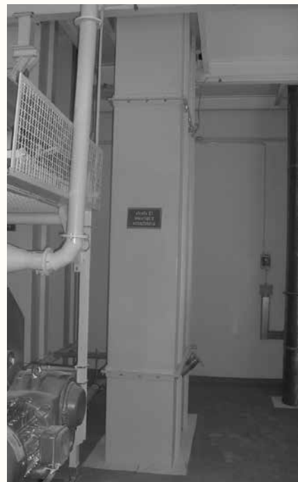
FOT. 1 Pionowy obudowany podnośnik transportowy w silosie na popiół [Chemadex S.A.]
