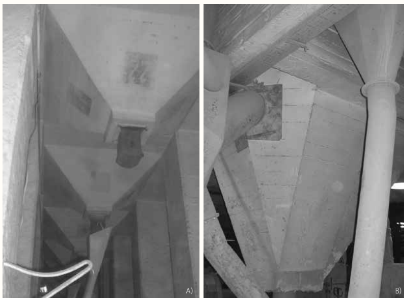
FOT. 8 Żelbetowe leje ostrosłupowe: a) wielokomorowego elewatora zbożowego, b) zbiornika operacyjnego w cementowni
