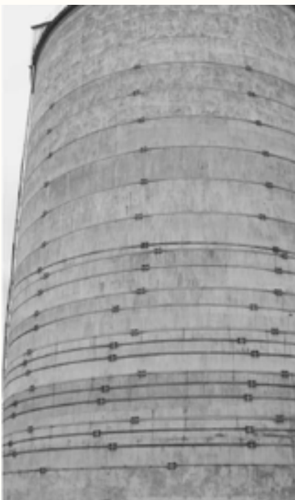
FOT. 2 Wzmocnienie silosu obejmami stalowymi: a) widok ogólny, b) szczegółowy
