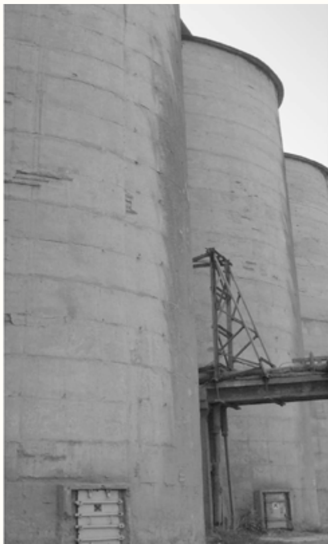
FOT. 1 Uszkodzenia ścian silosów na cement od strony zewnętrznej
