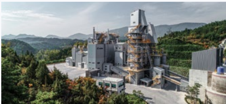
FOT. 1 Piec wapienniczy firmy Maerz Ofenbau AG wybudowany dla MDI Inc Korea
