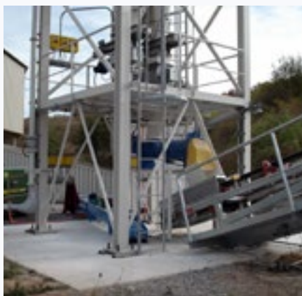
FOT. 2 Nawilżanie pyłu powstałego przy produkcji materiałów budowlanych
