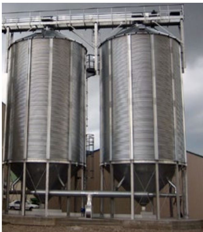
FOT. 2 Dwa silosy lejowe wykonane ze stali cynkowanej ognioowo
