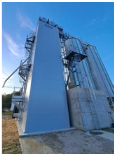
FOT. 1 Wyprodukowana przez TORNUM suszarnia połączona z silosami lejowymi
