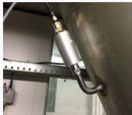
FOT. 12 Ultradźwiękowy system udrażniania silosu. Na zdjęciu głowica ultradźwiękowa [ŹRÓDŁO: Inżynieria Pro]
