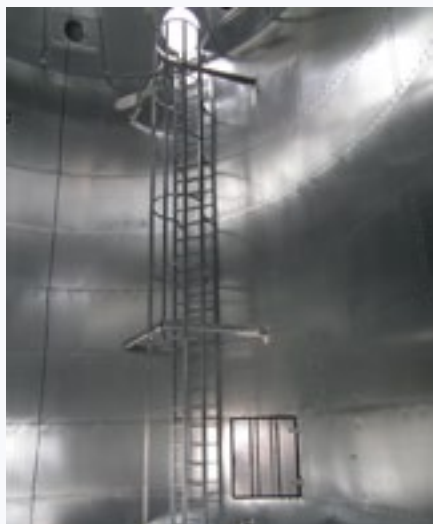
FOT. 11 Wnętrze silosu
