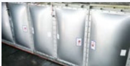
FOT. 3 Certyfikowane panele dekompresyjne z czujnikami otwarcia zabudowane na filtrze – prace uwzględniły wykonanie projektu i montaż ram adaptacyjnych dla nowych paneli
