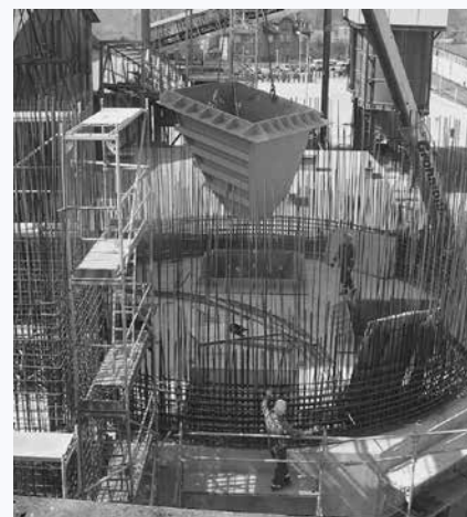
FOT. 9 Lej stalowy w silosie na klinkier w czasie montażu w jednym z czterech otworów wysypowych [Uniserv S.A.]
