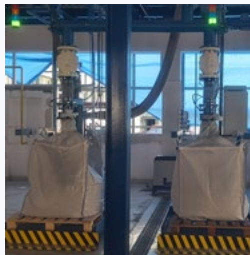
FOT. 5 Proces napełniania worków
