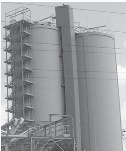
FOT. 1 Pionowy obudowany podnośnik transportowy w silosie na popiół [Chemadex S.A.]
