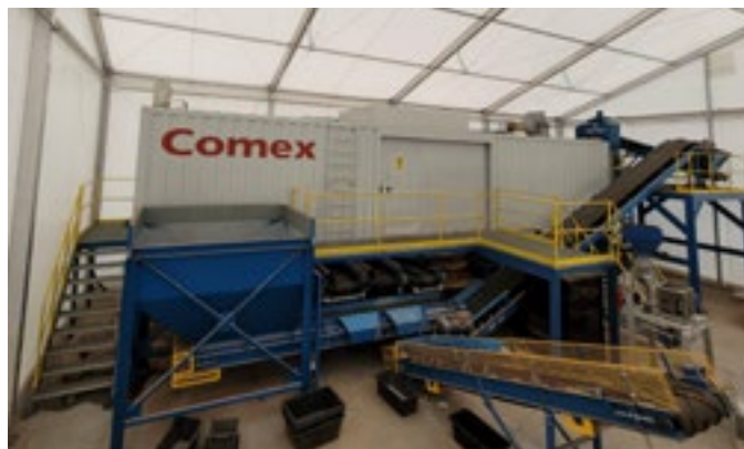
FOT. 6 Układ walidacyjny separacji optycznej i rentgenowskiej w zabudowie kontenerowej
