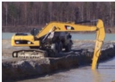
RYS. 2.6 Wydobycie spod wody żwirów i piasków koparkami podsiębiernymi z długim wysięgnikiem
