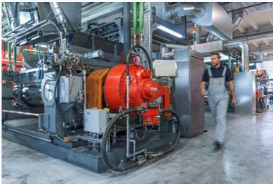
FOT. 2 Bezpośredni układ hydrauliczny
