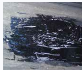
Po: Naprawa wyżłobienia z użyciem R-Flex
