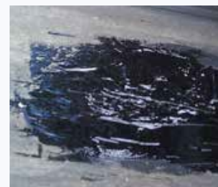
Po: Naprawa dziury z użyciem R-Flex
