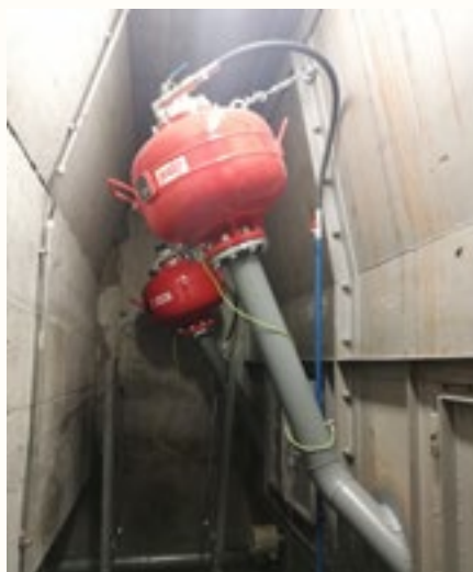
FOT. 1 Pulsatory SYNEX zamontowane na podajnikach ślimakowych
