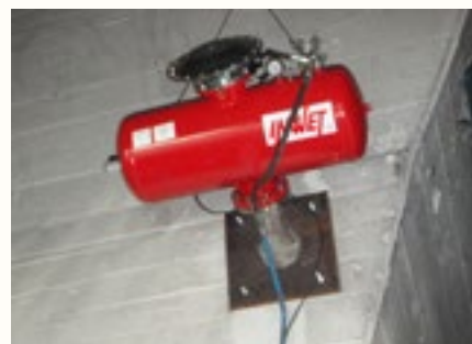
FOT. 4 Pulsator SYNEX EX w najbardziej znanym, podłużnym kształcie
