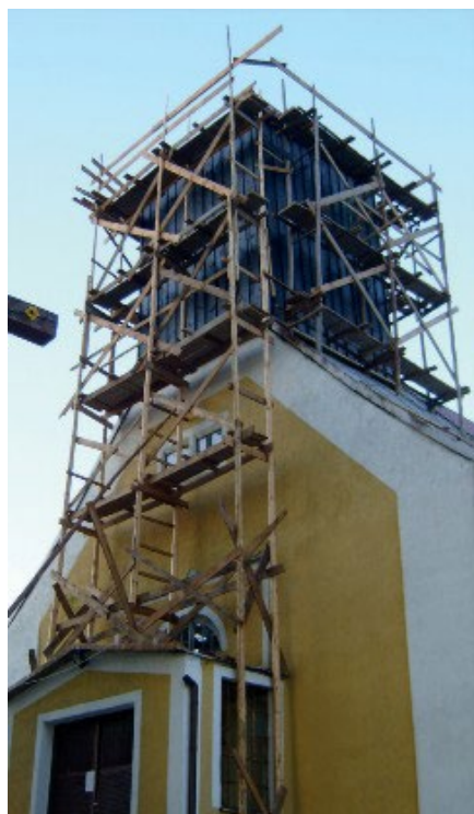
RYS. 1.13 Rusztowanie drewniane (przyściennie dwurzędowe)
