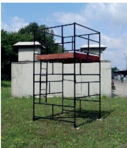
FOT. 1.5 Rusztowanie ramowe: a) zabudowa prosta, b) zabudowa cylindryczna, c) rusztowanie typu „Warszawa”
