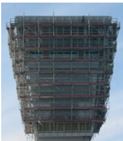
FOT. 1.1 Rusztowanie robocze
