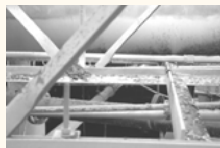
FOT. 2 (A) Pył zalegający w kanale, który stanowił paliwo dla rozwoju wybuchu wewnątrz instalacji. (B) Właz rewizyjny w kanale wyrwany przez ciśnienie wybuchu. (C) Pył zalegający w hali, który stanowił paliwo dla wybuchu wtórnego
