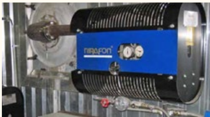
FOT. 2, 3 Zdmuchiwalca akustyczny Nirafon® NCSZ zainstalowany na obiekcie
