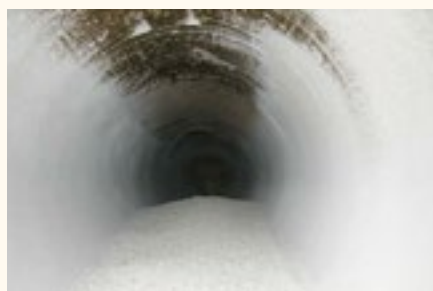
FOT. 2 (A) Pył zalegający w kanale, który stanowił paliwo dla rozwoju wybuchu wewnątrz instalacji. (B) Właz rewizyjny w kanale wyrwany przez ciśnienie wybuchu. (C) Pył zalegający w hali, który stanowił paliwo dla wybuchu wtórnego
