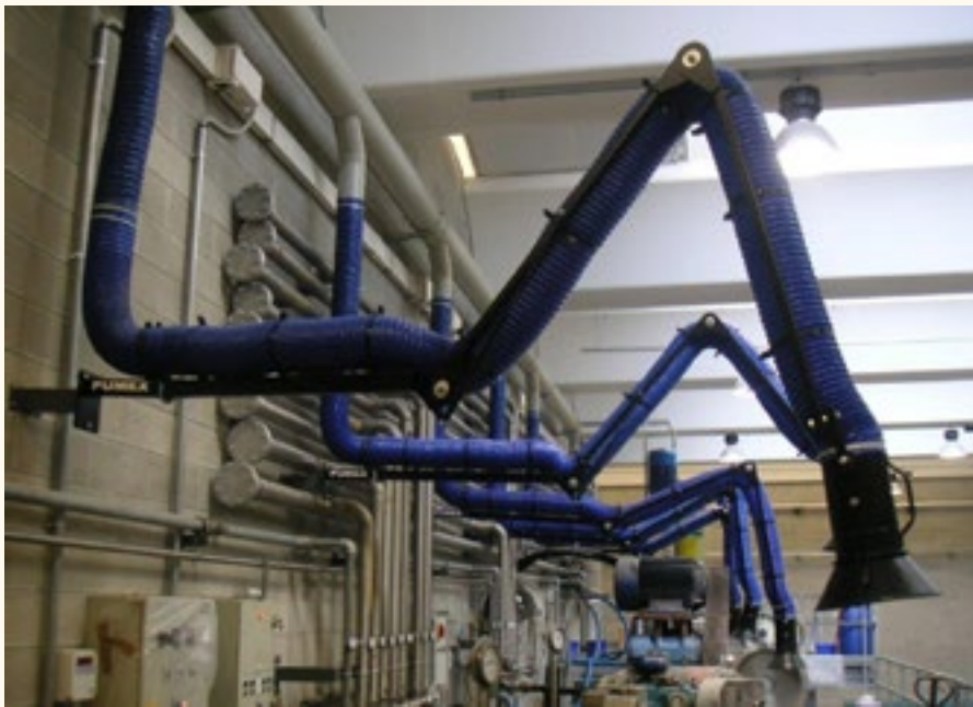
FOT. 4 Instalacja wentylacji wielostanowiskowej
