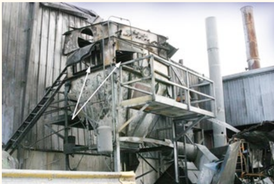
FOT. 1 Wybuch pyłu w filtrze przedostał się pyłoprzewodem do hali, gdzie doprowadził do potężnego wybuchu wtórnego i pożaru
