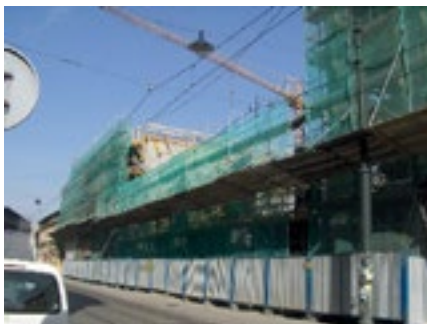
FOT. 1.2 Rusztowanie ochronne z daszkiem ochronnym
