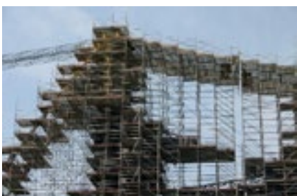
FOT. 1.7 Rusztowanie modułowe (klatkowe)
