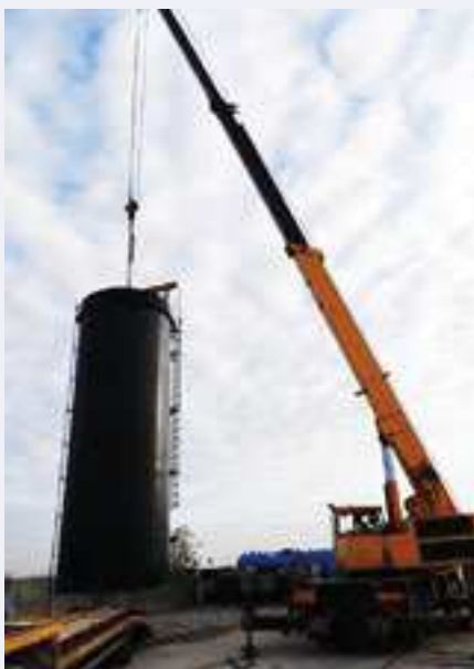
FOT. 1 Zbiornik na ług sodowy – transport i montaż.
