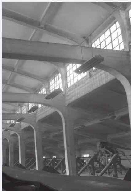
FOT. 4 Żelbetowa konstrukcja ramowa galerii nadsilosowej w elewatorze zbożowym z okresu międzywojennego
