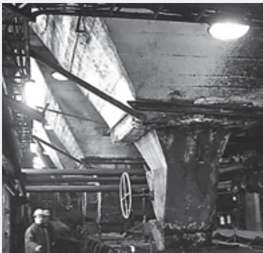
FOT. 7 Przewody stalowe odbierające węgiel z otworów wysypowych bunkra: a) w budynku płuczki, b) w elektrociepłowni – przewody doprowadzające węgiel do paleniska
