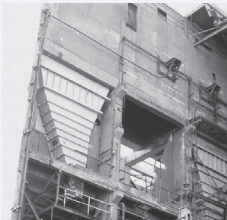
FOT. 9 Jednorzędowa bateria silosów z lejami stalowymi w kotłowni, w czasie remontu
