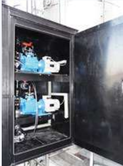
FOT. 3 Szafa chemoodporna zabudowa pomp dozujących ługu sodowego
