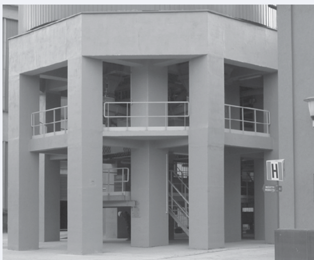
FOT. 7 Przykład konstrukcji silosu z dolną częścią w formie ramy przestrzennej, na której opierają się ściany i płyta dolna
