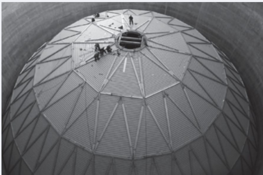
FOT. 3 Stalowa konstrukcja kopuły silosu na cukier [Chemadex S.A.]
