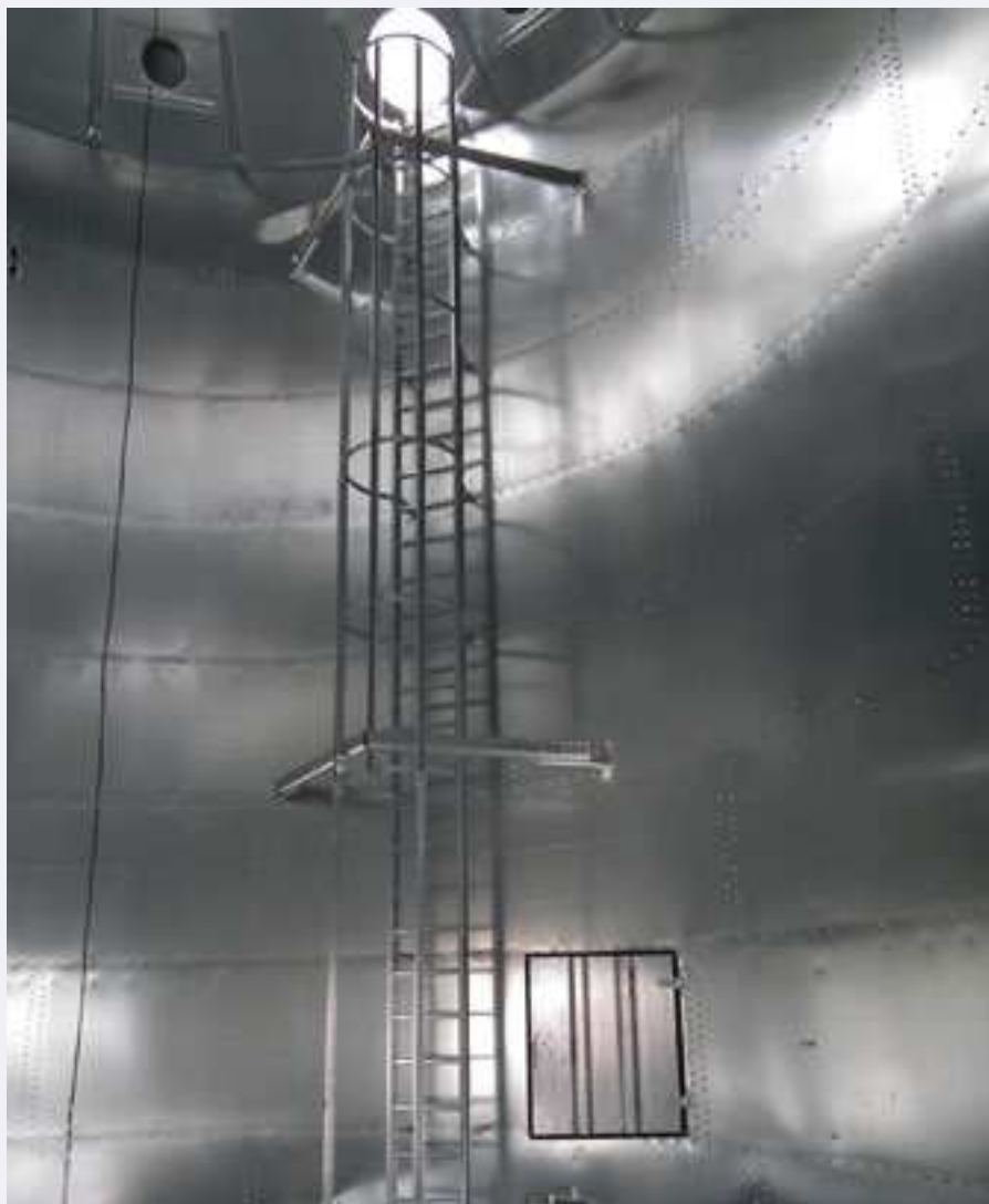
FOT. 11 Wnętrze silosu
