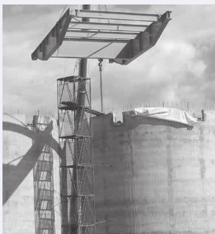
FOT. 6 Montaż stalowej konstrukcji pod galerią stalową żelbetowy strop silosu [ŹRÓDŁO: Uniserv S.A.]
