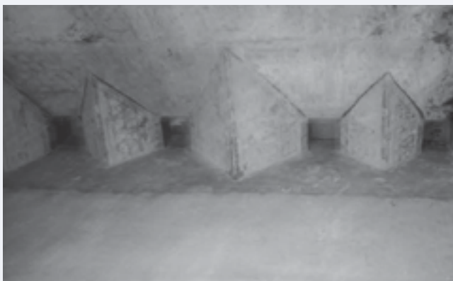
FOT. 6 Bunkier na węgiel opróżniany niecentrycznie, ze ścianami kotwionymi w słupach szkieletowej konstrukcji budynku elektrociepłowni: a) ściana tylna, b) widok od szczytu bunkra, c) wnętrze bunkra widziane z góry
