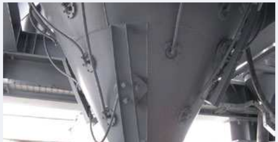
FOT. 17 System aeratorów grzybkowych [Źródło: WAM Polska]
