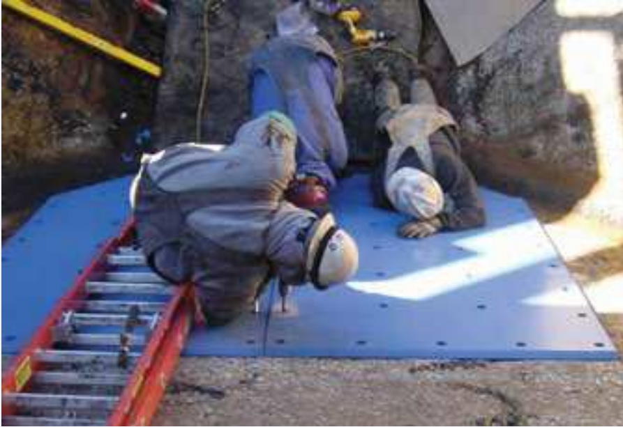
FOT.5 Montaż paneli okładzin ściennych silosu [źródło: QUADRANT EPP POLSKA]
