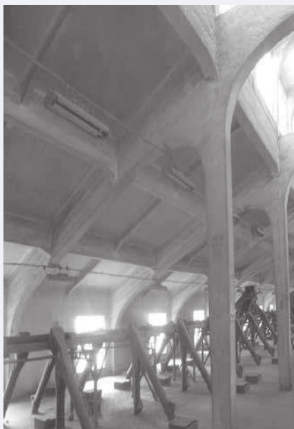
FOT. 4 Żelbetowa konstrukcja ramowa galerii nadsilosowej w elewatorze zbożowym z okresu międzywojennego
