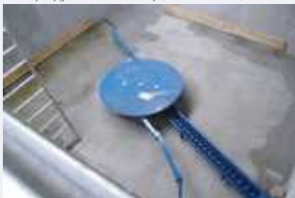
FOT. 2 Wygarniacz z uchylnymi ramionami. Materiał jest wygarniany ze stalowych lub betonowych silosów. Wygarniacz zamontowany jest bezpośrednio na dnie silosu [ŹRÓDŁO: Fortech]
