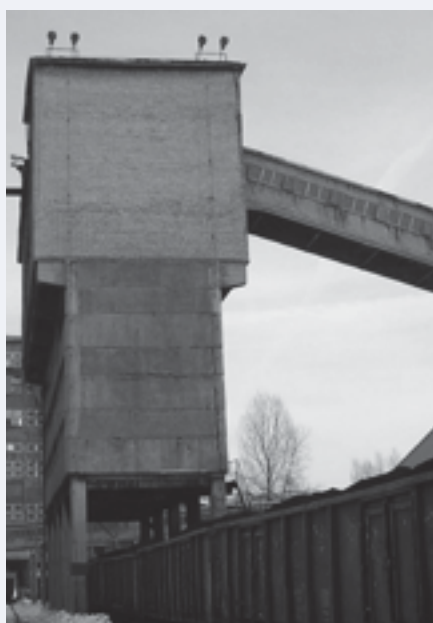
FOT. 4 Budynek klasyfikacji wstępnej węgla w kopalni z bunkrem w centralnym segmencie – konstrukcję stanowią ramy żelbetowe
