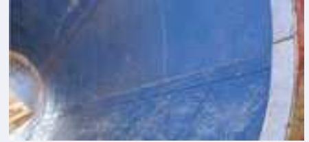
FOT.6 Lej wyspowy silosu obłożony okładzinami w systemie TIVAR Engineering [źródło: QUADRANT EPP POLSKA]
