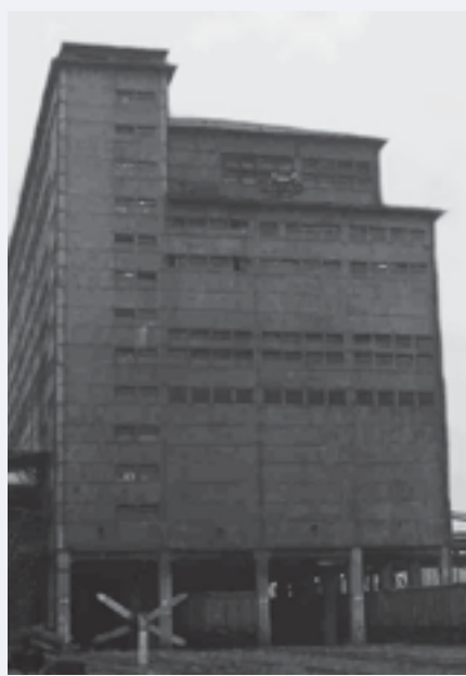
FOT. 5 Budynek płuczki węgla w kopalni z zespołem żelbetowym bunkrów na węgiel – konstrukcja mieszana żelbetowo-stalowa
