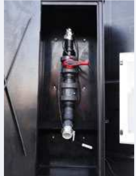
FOT. 4 Zawory – instalacja sody kaustycznej.
