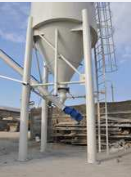
FOT. 14 System aeracji firmy Betonwerk. Dysze montowane są w płaszczu silosu, a warunkiem prawidłowego działania systemu jest dostarczenie osuszonego powietrza
