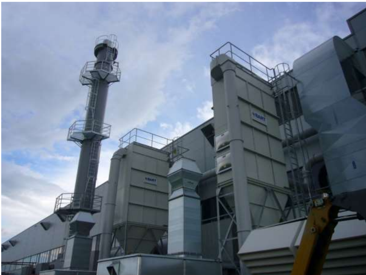
FOT. 2 Instalacja odpylania pyłów wybuchowych z zastosowaniem systemów bezpieczeństwa – na urządzeniu filtracyjnym umieszczono panele dekompresyjne
