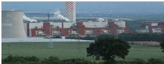
OCZYSZCZANIE SPALIN KOTŁOWYCH
