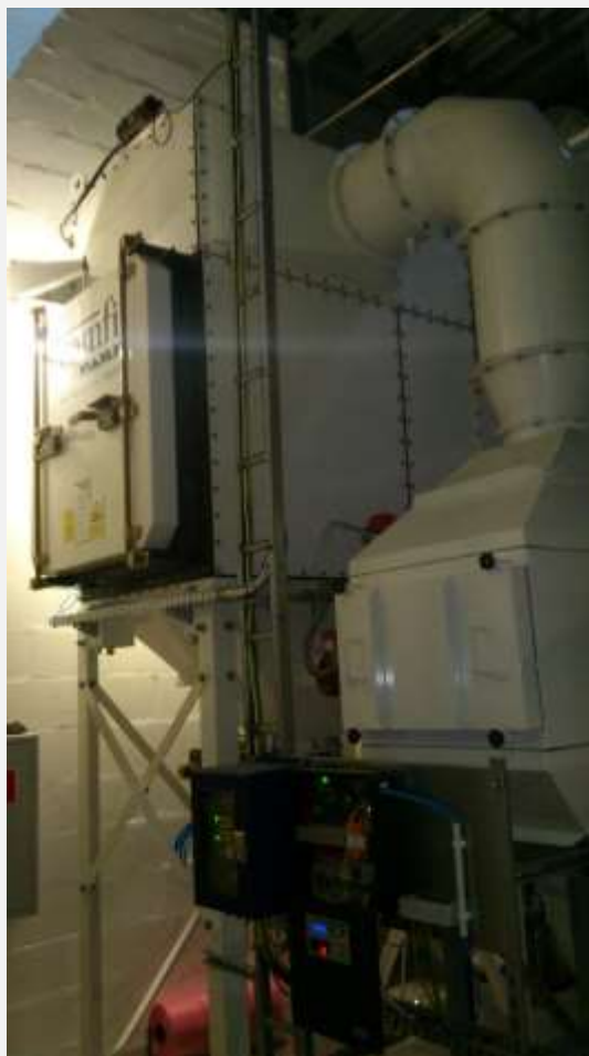
FOT. 5 Odpylanie o wydajności 6000 m 3 /h w czasie produkcji farmaceutyków. Instalację tę firma BART wykonała w wersji ATEX zabezpieczonej przeciwwybuchowo systemem HRD
