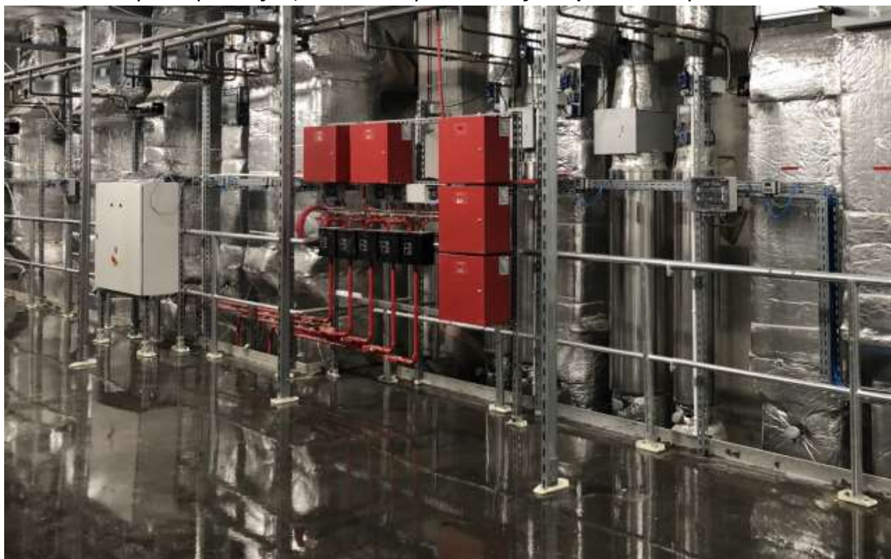
FOT. 2 Realizacja firmy BART w branży farmaceutycznej: modernizacja instalacji wentylacyjnej oraz montaż nowej podczas rozbudowy powierzchni hali, w której produkuje się wyroby lecznicze – o wydajności ponad 122 tys. m 3 /h. Wykorzystano ok. 7 tys. m 2 przewodów wentylacyjnych
