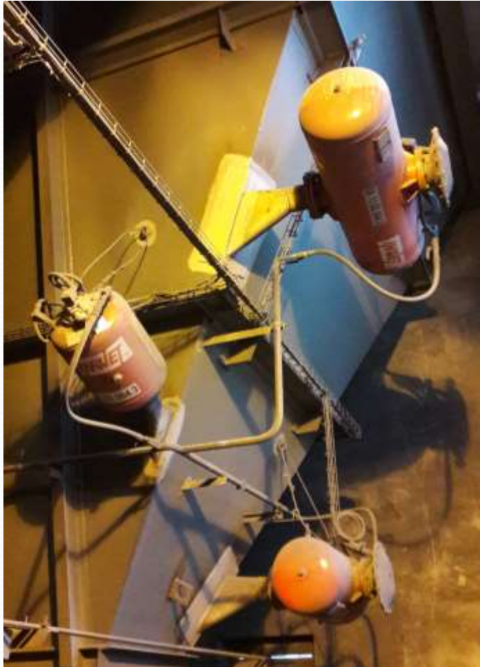
Pulsatory pneumatyczne SYNEX na stalowym zbiorniku węglowym
