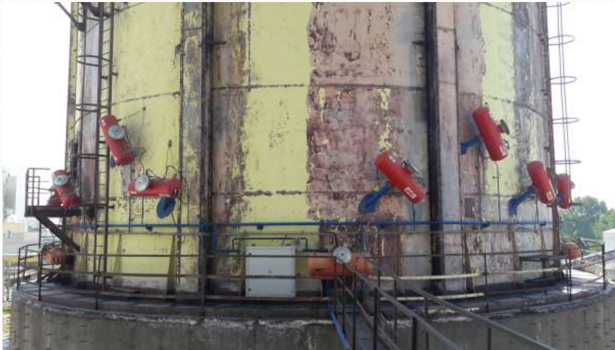
Pulsatory pneumatyczne SYNEX na stalowym silosie sody
