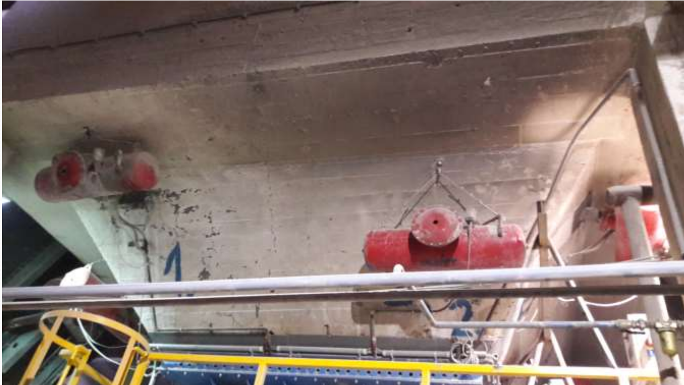
Pulsatory pneumatyczne SYNEX na zasobniku żelbetowym kamienia wapiennego
