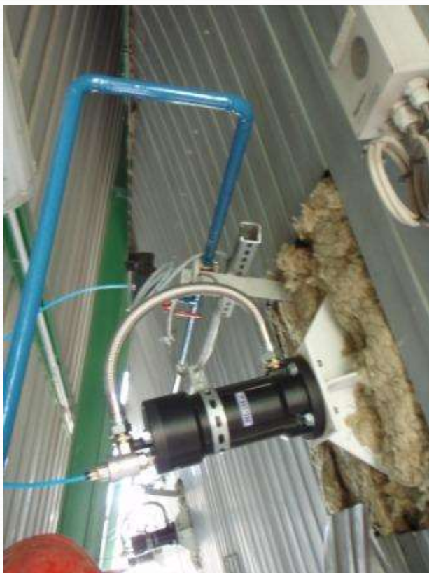
Odbijak pneumatyczny na leju filtra workowego
