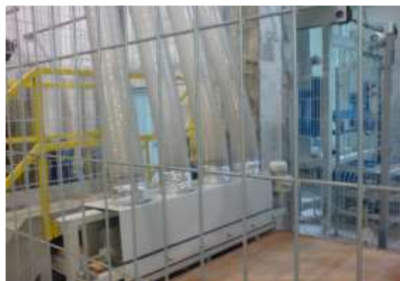
Zamontowany układ ssący na stanowisku oczyszczania kostki brukowej
